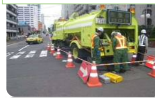
高圧洗浄車にて管内を洗浄します。
