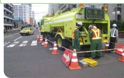
高圧洗浄車にて管内を洗浄します。
