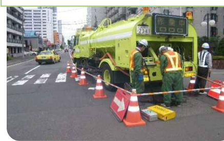
高圧洗浄車にて管内を洗浄します。
